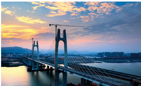
福厦高铁安海湾特大桥建设纪实 许玲珍摄
