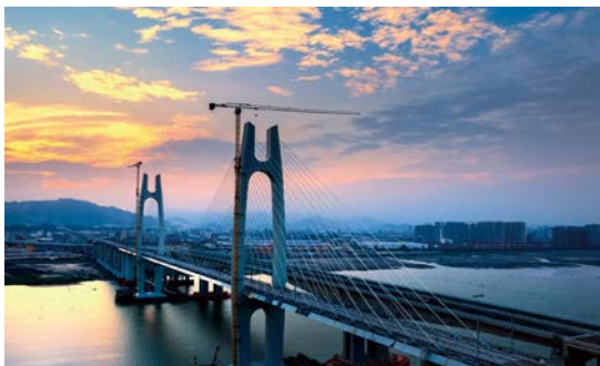
福厦高铁安海湾特大桥建设纪实 许玲玲摄
